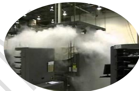
EXTINCIÓN DE AGENTE GASEOSOS
